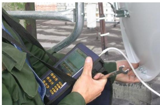
Если же у Вас прибора нет, то можно настраивать антенну, отслеживая уровни сигнала по шкалам тюнера. Ресивер подключаем к телевизору, только после этого включаем питание 220В. Включаем телевизор, ресивер, заходим в меню Установка-Поиск каналов. Меню настройки LNB, выбор спутника, поиска каналов могут несколько отличаться в зависимости от модели тюнера, но сам принцип остается тем же.
