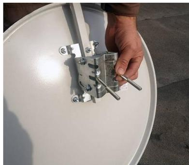
**2. Установить конвертор в держатель, а затем держатель с конвертором установить на штангу антенны.**
