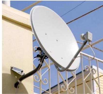
**4. Подключить кабелем спутниковый тюнер к конвертору антенны.** Для этого отмеряем длину кабеля от конвертора спутниковой антенны до тюнера, прокладываем кабель, делаем обрезку кабеля с двух сторон и накручиваем F-коннекторы, подключаем его к ресиверу и конвертору антенны. Немаловажный момент-при накручивании на кабель F-коннектора необходимо тщательно следить, чтобы тонкие проводники экранирующей оплетки кабеля не замкнулись с центральной жилой, иначе можно вывести из строя тюнер!!!
